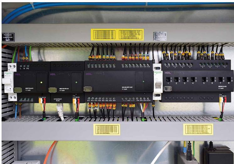
**A gestire alimentazione e comunicazione con l'esterno, i dispositivi HDL, con alimentatore, gateway, moduli di controllo accessi e modulo ingresso allarmi.**
